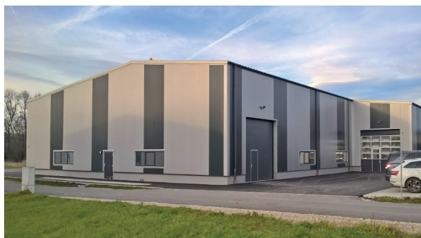
SKLADOVÉ A LOGISTICKÉ HALY
