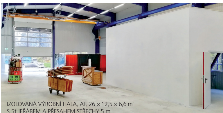
IZOLOVANÁ VÝROBNÍ HALA, AT, 26 × 12,5 × 6,6 m
